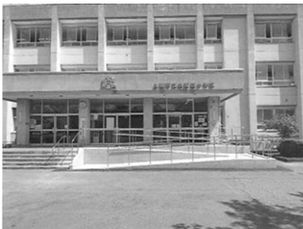
北諏訪小学校（玄関スロープ）
