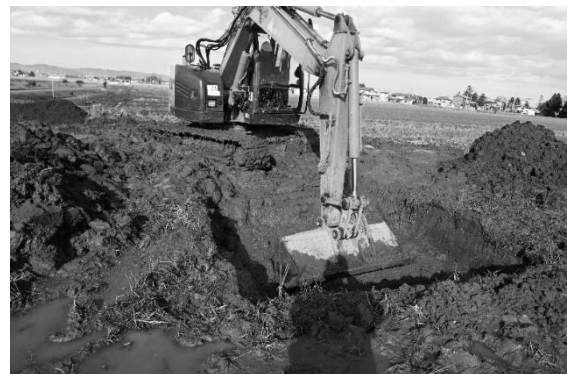
県営ほ場整備事業・高士南部地区 試掘調査風景
