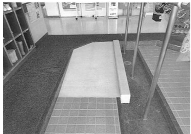
北諏訪小学校（昇降口内部）
