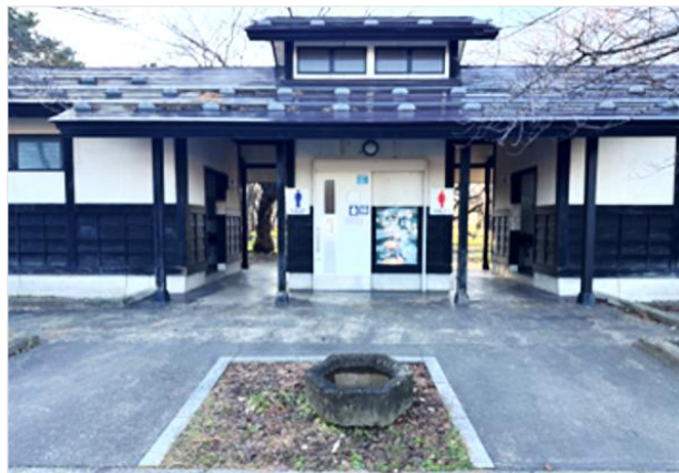
高田城址公園東入口便所(図書館北側トイレ)
