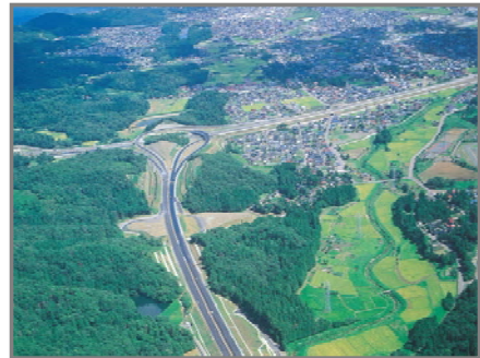
北陸自動車道と上信越自動車道が交わる 上越ジャンクション
