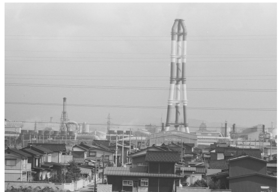
直江津の工場地帯（昭和 52 年）
