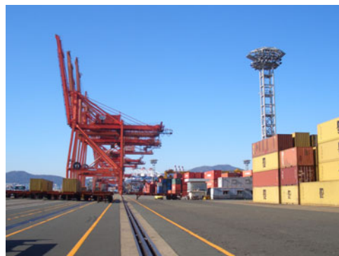
写真 3-1 プサン港ふ頭状況
