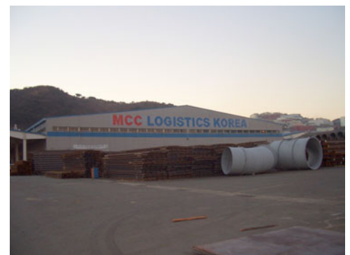
写真 3-2 プサン港(甘川港) MCLK 倉庫
