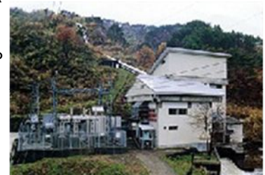
高田発電所(上越利水事務所 HP より)
