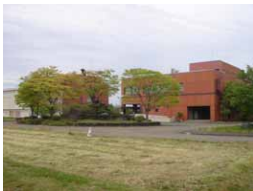
上越市下水道センター
