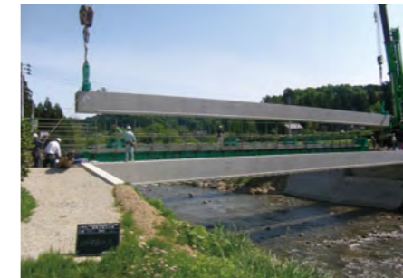
▲ 市道橋梁工事の様子 (安塚区 大原橋)
