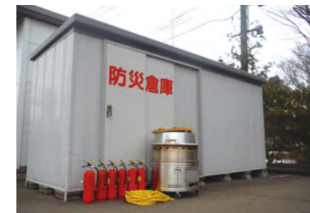
▲災害時に必要な資機材を保管する防災倉庫
