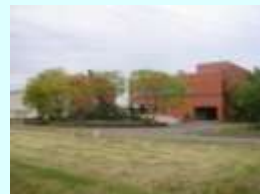
上越市下水道センター
