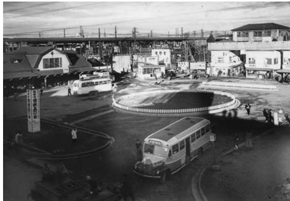
「昭和26年11月 中野駅南口広場工事完成」（中野区提供）
