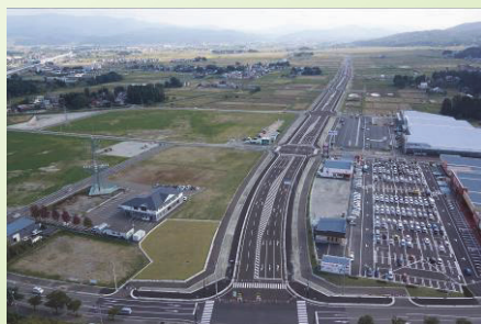
主要地方道上越新井線 （上越妙高駅周辺地域）
