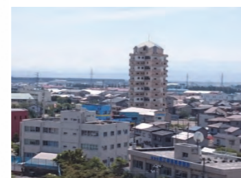
津波避難ビルとなっている 特定公共賃貸住宅 (直江津周辺地域)
