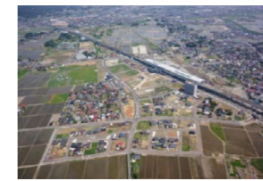
上越妙高駅西口と釜蓋遺跡
