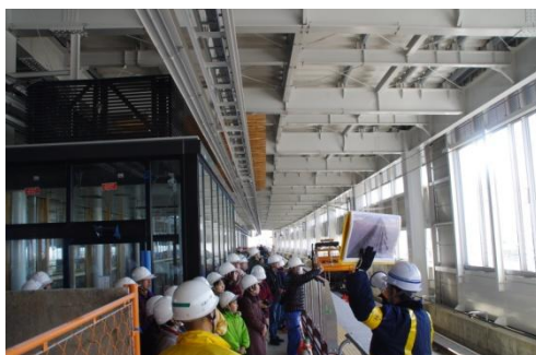
建設中のホーム
