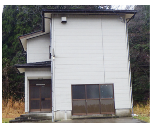
谷口ふれあいセンター ※警戒区域内のため速やかに宝田小学校体育館へ避難が必要
