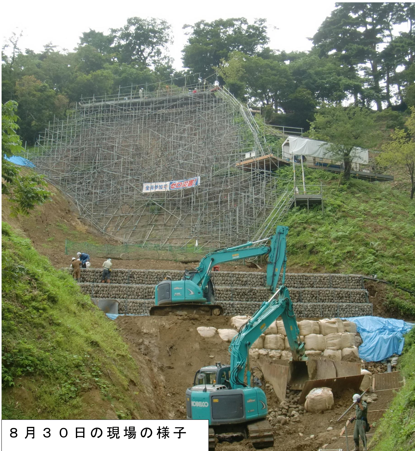
急傾斜の上部は、挿入した鉄筋でパネルを押さえ、今後の崩落を防ぎます。
