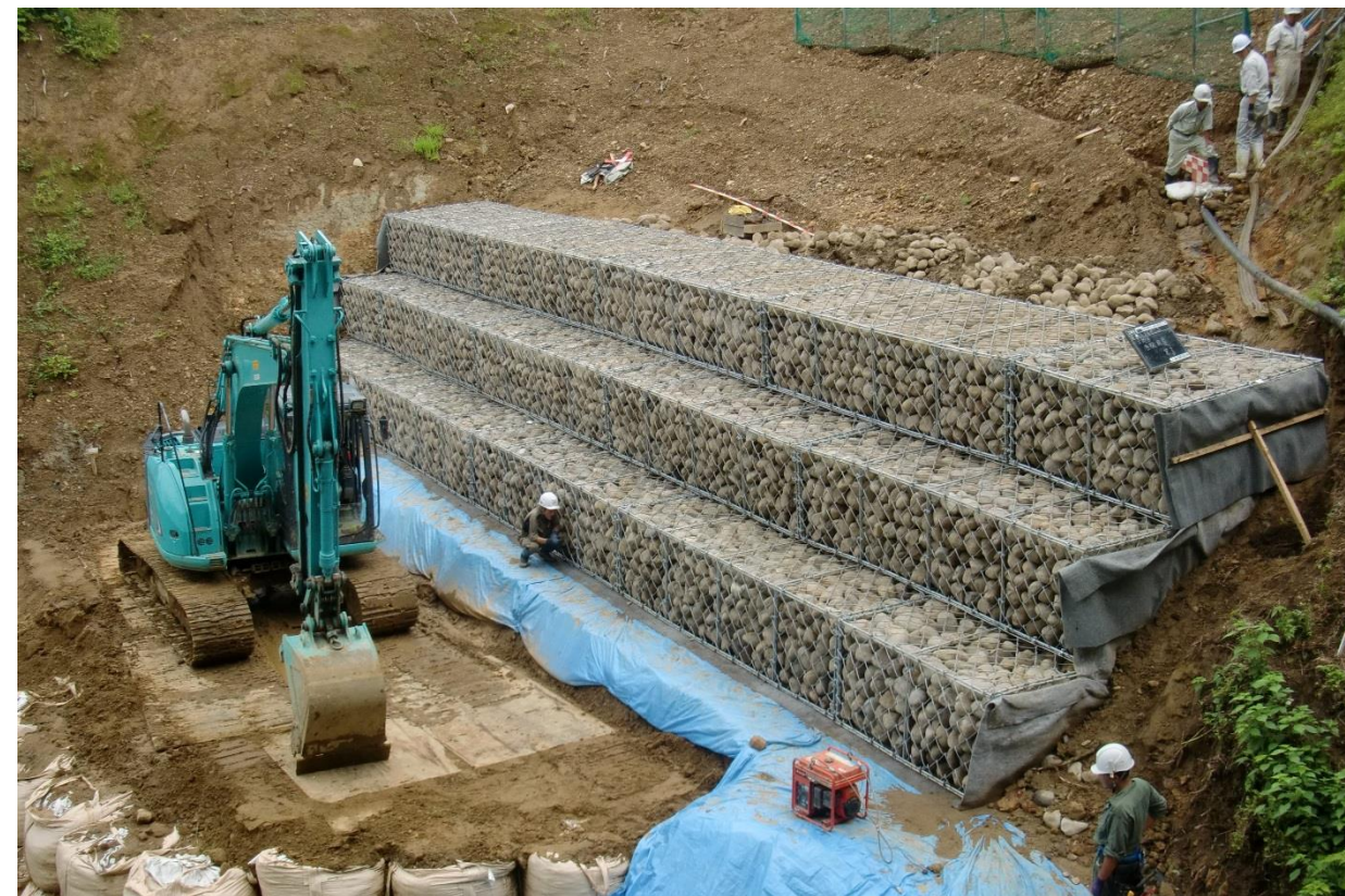
土留めのためのフトンカゴを設置しました。
