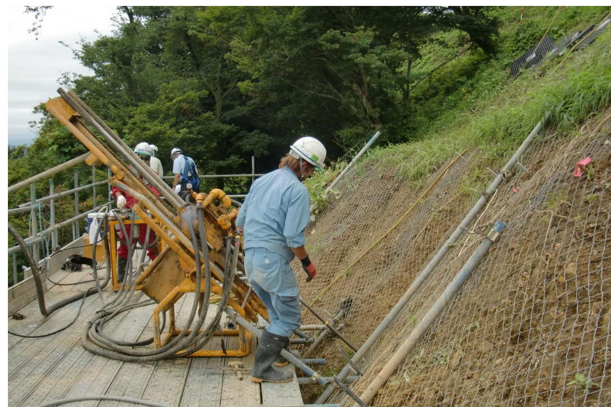
急傾斜の上部は、挿入した鉄筋でパネルを押さえ、今後の崩落を防ぎます。
