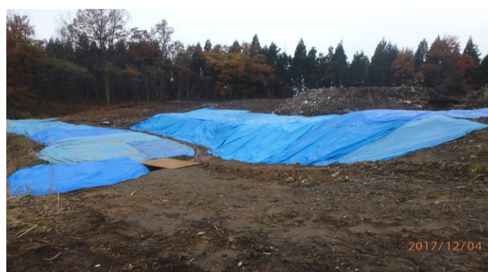
法面などをシートで被い廃棄物の流出防止策を実施
