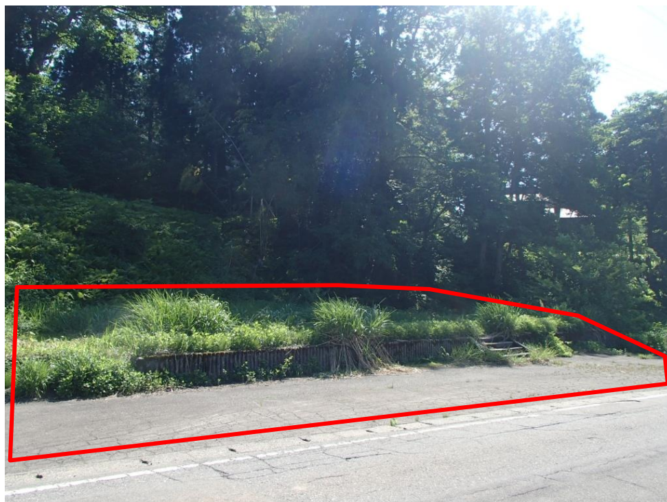
↑南東側から北西側向きに撮影
