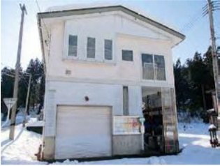
石橋地区集落開発センター ※石橋町内会が定めた一時集合場所 ※警戒区域内のため速やかに安塚中学校へ避難が必要
