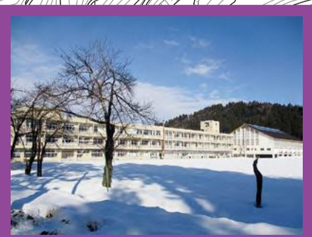
安塚中学校 ※避難所が警戒区域内であることから、避難時は2階以上を利用するよう注意が必要
