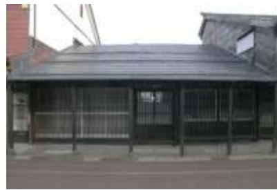
動線を確保するための改修箇所(現況)
