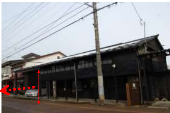
車両が通過できるように軒高を上げる改修を行う場合のイメージ（左）、参考：現況（右）
