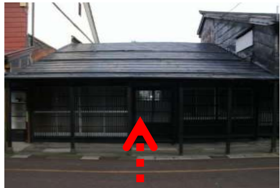
駐車場への導線確保のため北側張出し部を改築
