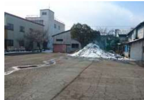
旧今井染物屋裏駐車場の現況
