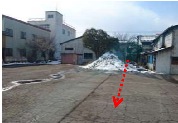
来訪者のための駐車場舗装整備
