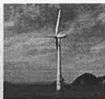
洋上風力発電施設 (H28環境白書より)
