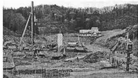
エコパークいずもざき第3期増設工事
