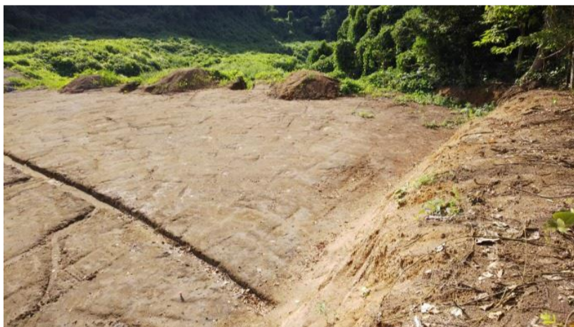
山側から谷側方向を撮影 (平成30年8月20日)
