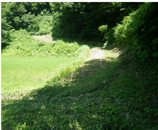
農道舗装箇所
