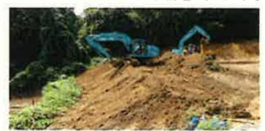
▲ ⑦成形…谷側の斜面を削り、安定勾配を確保し、土砂の崩落を防ぐ。
