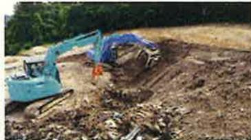
▲ ②選別…回転式とグローブ型の重機の連携により作業効率を上げる。
