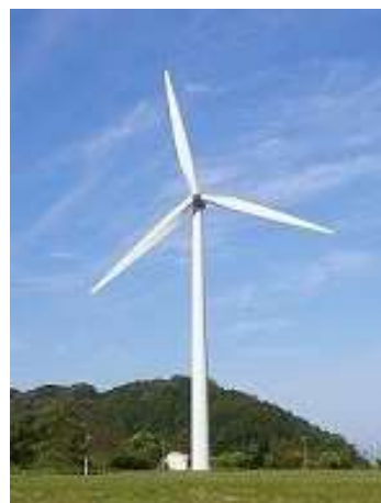
風力発電施設3号機
