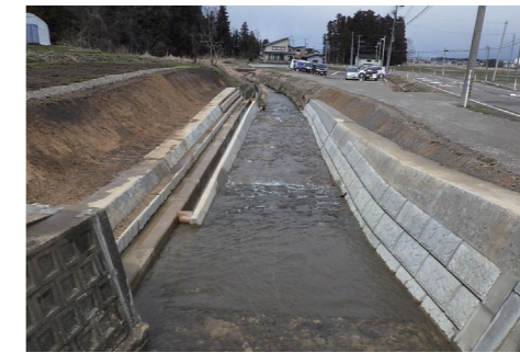
▲改修された河川(準用河川前川)
