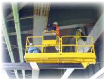
▲橋梁の点検作業
