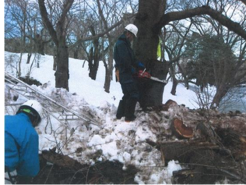
図 24 腐朽部切除の様子
