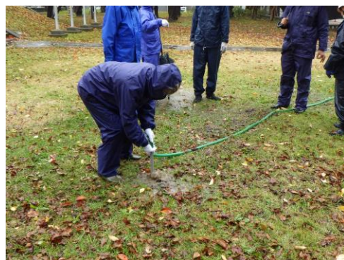
図 28 土壌改良(水圧式)の様子
