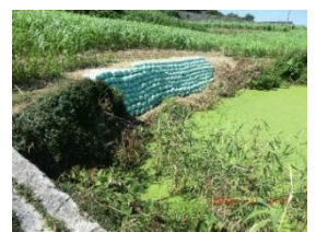
土のうによる崩落箇所の拡大防止
