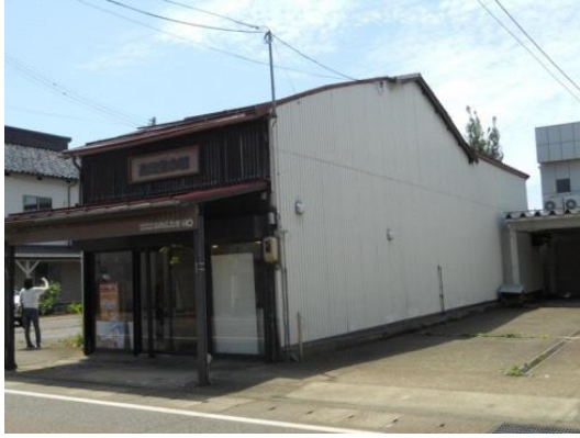
改修前：広告代理店事務所として営業
