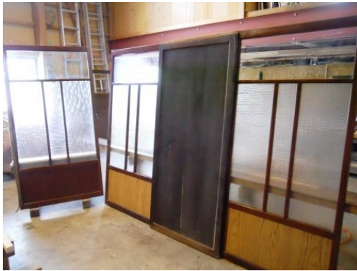
工事中：古い建具を再利用
