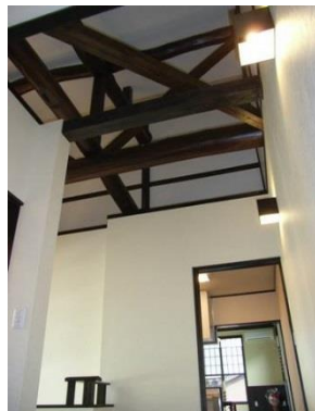
小屋組を現わした屋内
