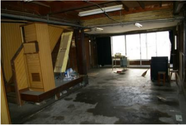
急勾配の木造階段を撤去し鉄骨造に取替
