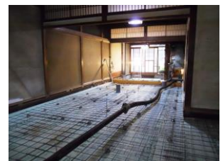
土間床断熱と土間コン
