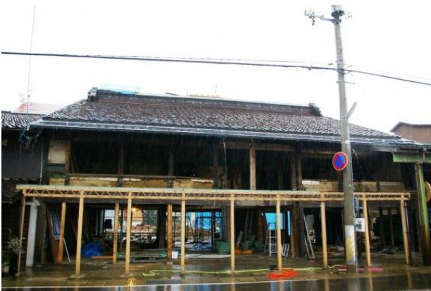
鉄骨造雁木は撤去し、木造の雁木に改築
