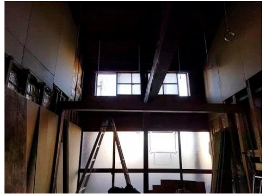
改修中：ミセ 2 階床撤去
