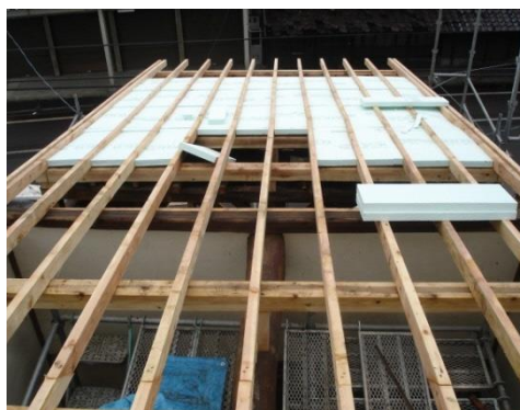
垂木を取替、屋根面に断熱施工
