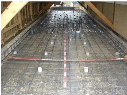
床下環境を安定化し、両側基礎を一体化
