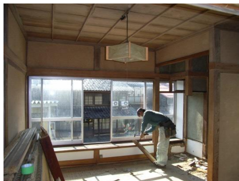
和室天井と床の間造作、ケヤキ部材を保存活用
