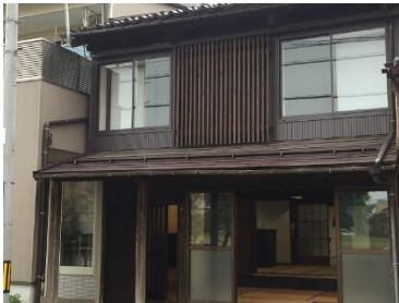
室外機隠しの木格子
