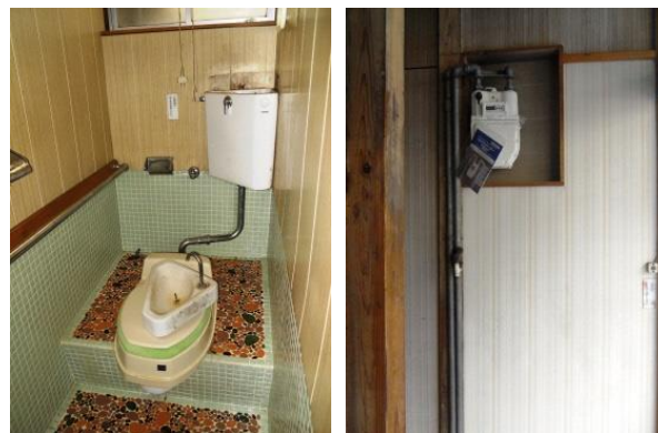
改修前1階便所 ガスメーター回り
