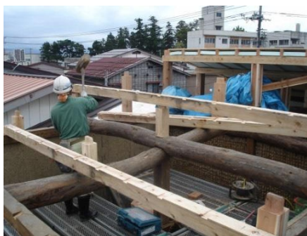
屋根部材撤去後、屋根勾配変更
