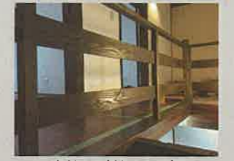
虎材から製作した手摺り
