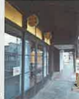
木格子で室外機を隠す
