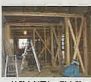
柱を新設して耐力壁に
