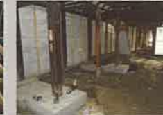
基礎新設の様子
