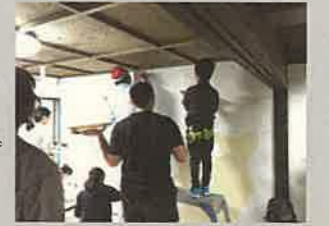
内壁漆喰塗りの様子
