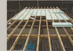
屋根改修の様子
