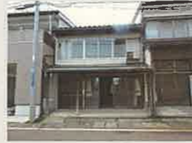
シェアハウス大町 改修前
