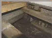
シェアハウス大町 改修前の基礎の様子
