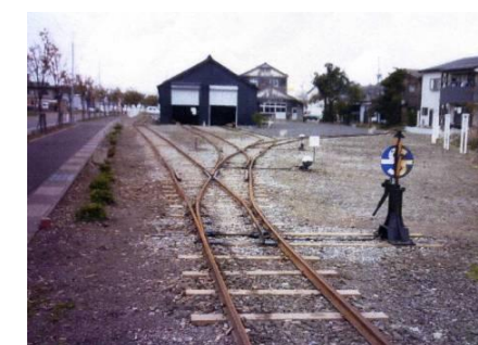
▲構内に敷設された線路
