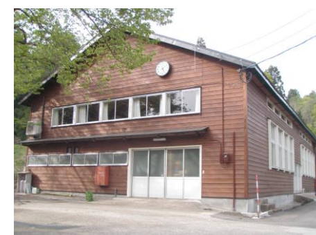
▲整備後の外観
