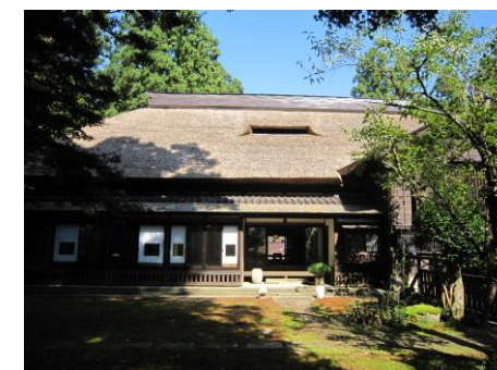
▲屋根茅葺替え後の外観
