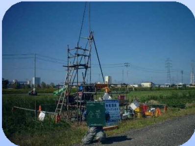
【ボーリング地質調査】
