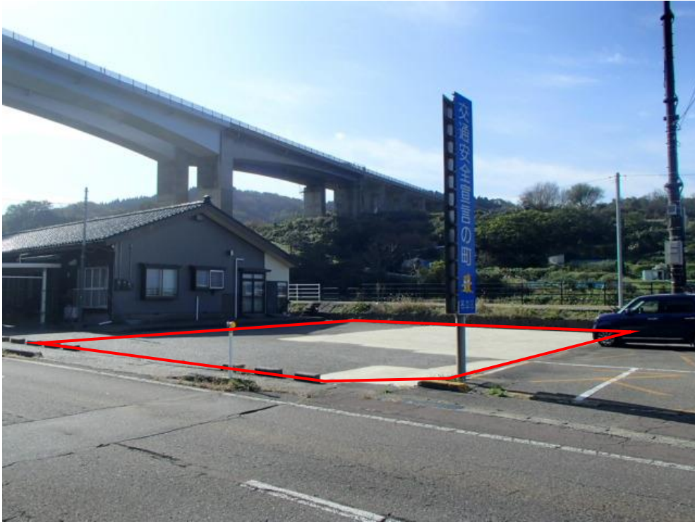
▲北東側から南西向きに（県道側から）撮影
