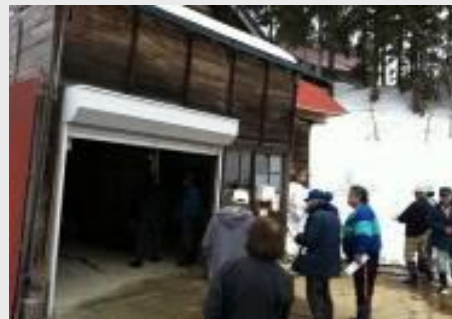
現地で被災状況を確認
