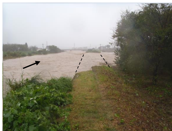
令和元年東日本台風に伴う豪雨 関川水系矢代川の堤防決壊 （上越市西田中地内）
