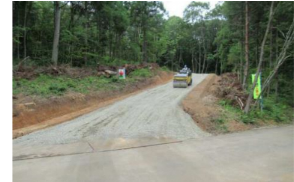
【仮設施設 (山地)】
