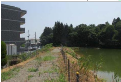
※堤体下流にマンションが隣接
