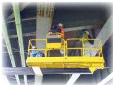
▲橋梁の点検作業
