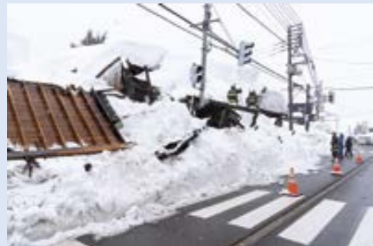
雪の重みで倒壊した家屋(上/南本町1、下/東本町3)
