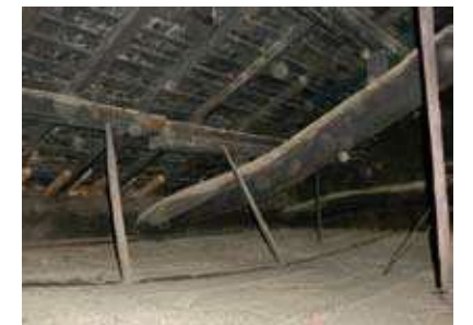
屋根裏の様子
