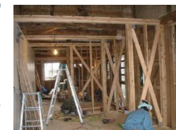
写真② 開口部だった所に壁を増設→
