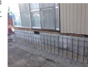
鉄筋の入っていない基礎に鉄筋を外からかぶせている例
