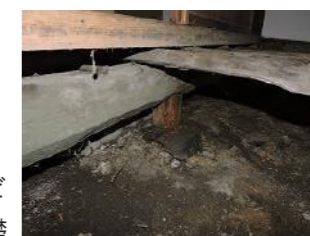
古い町家の基礎の例
