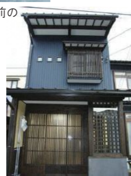
改修した町家住宅。→ 雁木も街並みに合わせて改修
