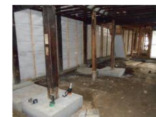
改修で基礎を作っている例
