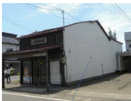
隣がなくなった後の外壁
