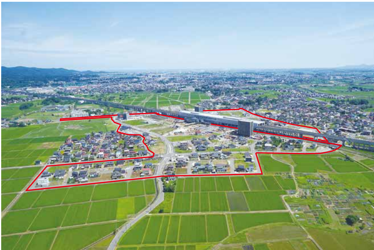
整理後 全景 (平成30年7月)
