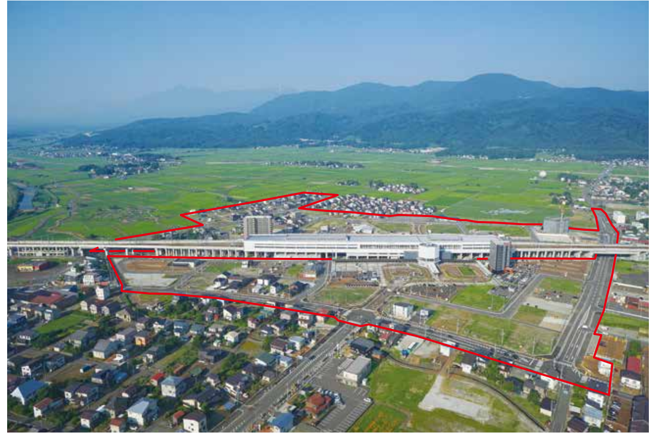
整理後 東側から西側を望む (平成30年7月)
