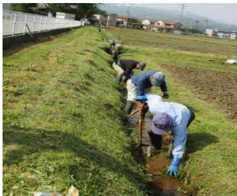
水路の泥上げ
