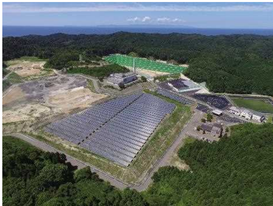
エコパークいずもざき 1期処分場の太陽光発電施設 ※発電規模は一般家庭の364世帯分
