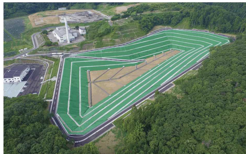
第3期処分場（全景）
