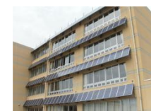
大町小学校の太陽光発電
