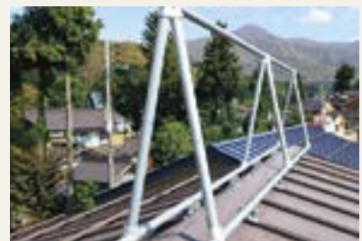
命綱固定アンカーの設置例
