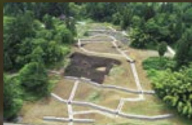
施工した細入地区(浦川原区谷地内)の災害関連緊急地すべり対策(治水)工事。
