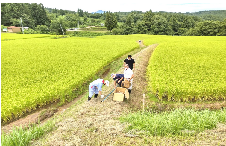
ソーラーライト設置作業の様子（8/21）
